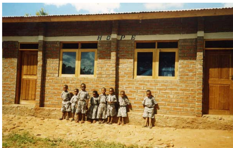
Ein Klassenzimmer von außen. Nebenan wurde gerade der neue Speisesaal gebaut.
